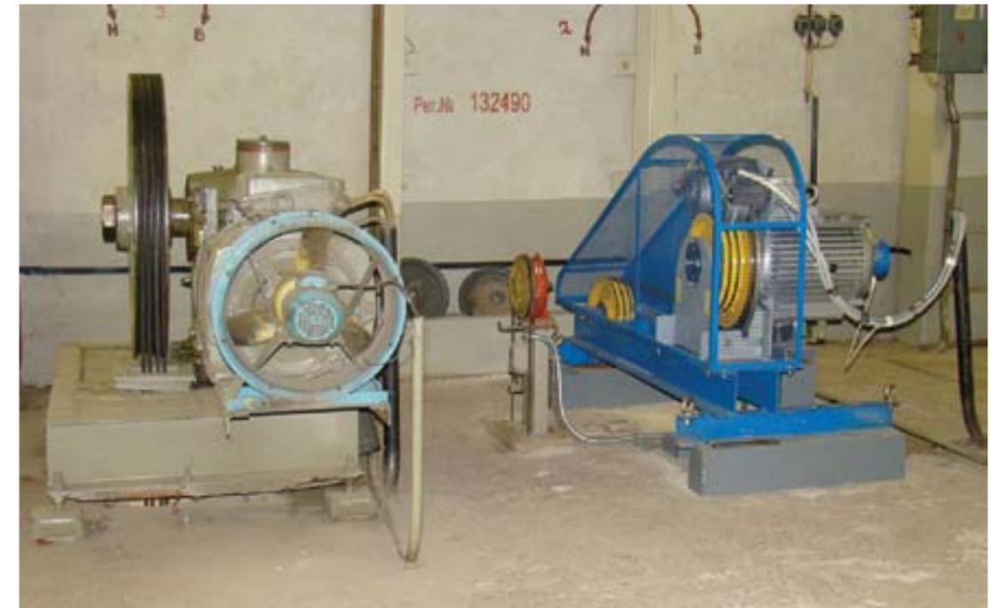
**Редукторная лебёдка с двухскоростным двигателем и безредукторная лебёдка (после замены, в том же помещении)**
